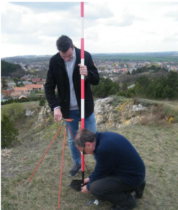
3.3. ábra A 101-es pont kitűzése
