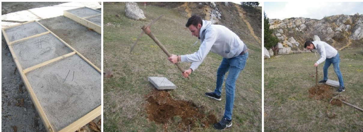
3.5. ábra A betonlap kiöntése és a földmunka
