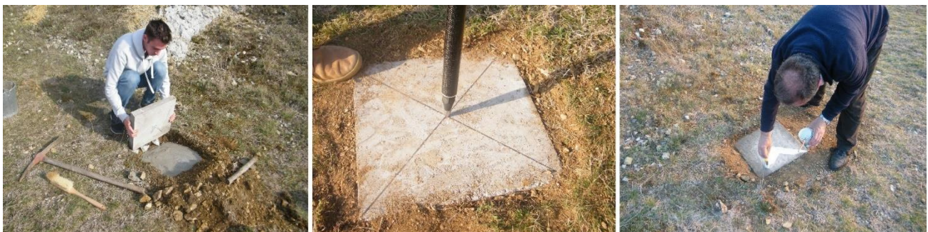
3.6. ábra A kőlap állandósításának befejező lépései
