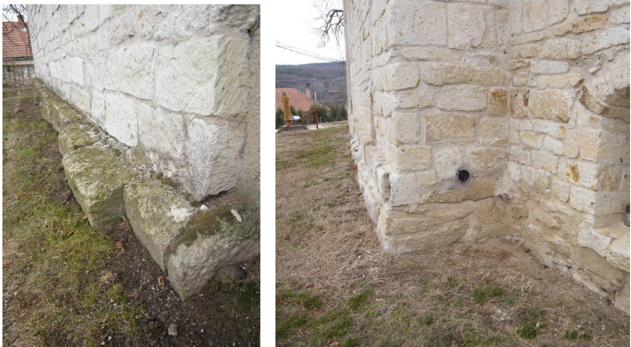
3.11. ábra. Az alapozás lábazata északon és délen
